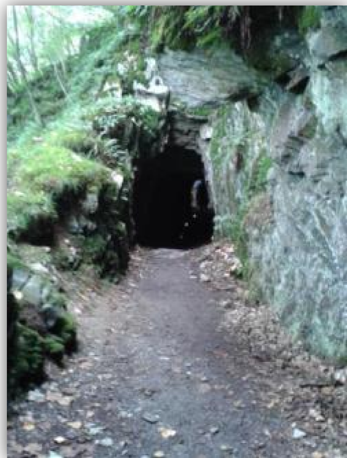
Abbildung 13: Der Weg führt durch zwei Tunnel
